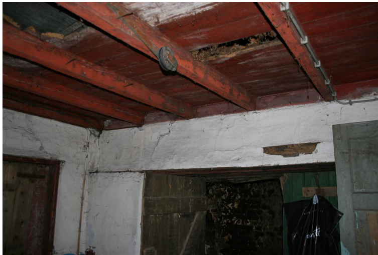
Balkenplafond in de herd
