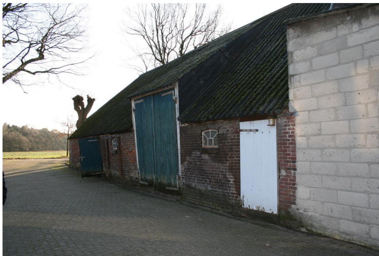
Rechterzijgevel vanaf de achterzijde
