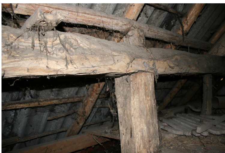
Gebintplaat op zolder
