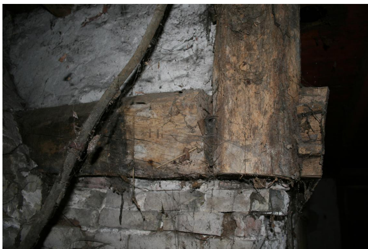
Ankerbalkgebint ter hoogte van de schouw
