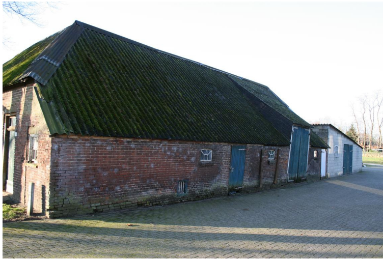
Rechterzijgevel vanaf de straatzijde
